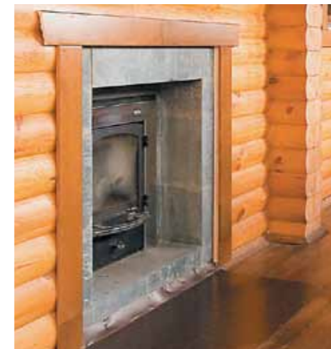
Облицовка плиткой из талькомагнезита портала банной печи
