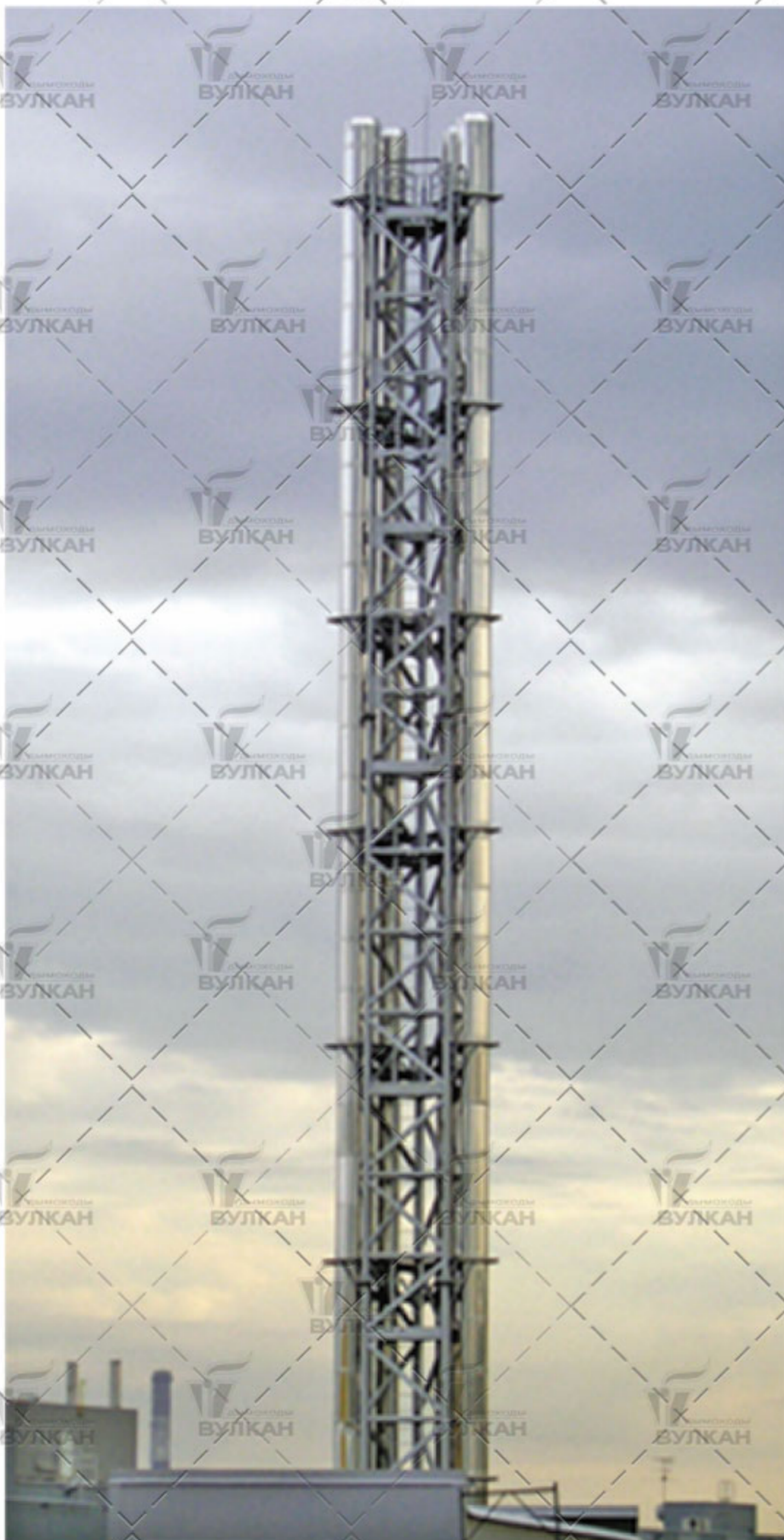
Гипермаркет ОКЕЙ ул., Коллонтай Четыре дымохода высотой 38 м. Ø 600/700 Ø 400/500
