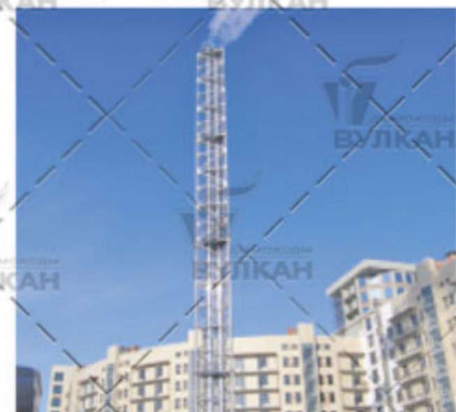
Коллективная котельная. Высотой 48м. Ø 600/700
